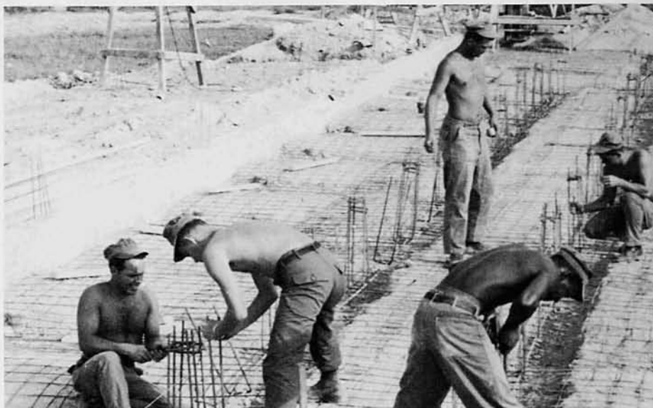
Tying rebar at Hue Interroga- tion Center
