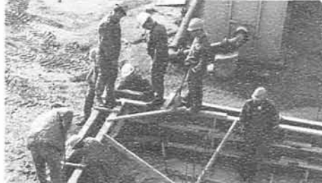
Inspecting the pour
